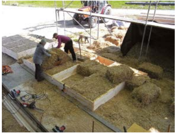
8. Lückenloses Einsetzen des zweiten Endballens neben dem ersten mittels Gleitplatten.
