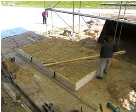
13. Einbau der oberen Klemmleisten.
