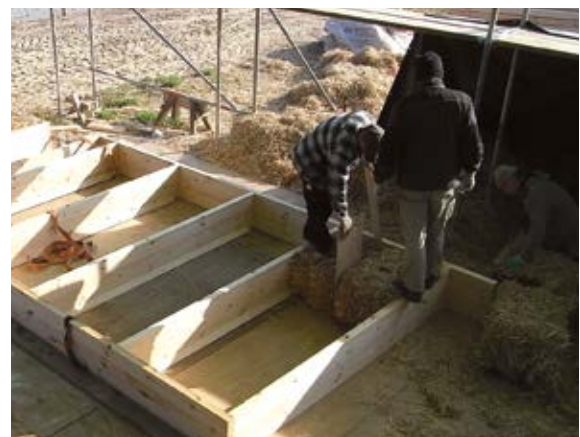
4. Eindrücken der Ballen mittels Körpergewicht.
