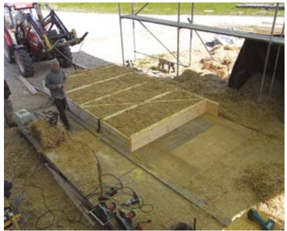
14. Fertiges Wandteil. Herstellungsdauer ca. 4 Stunden.
