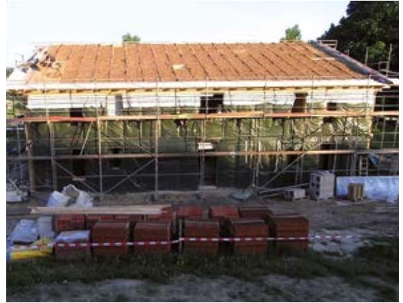
4. Aufbringen einer Lage Lehmputz.
