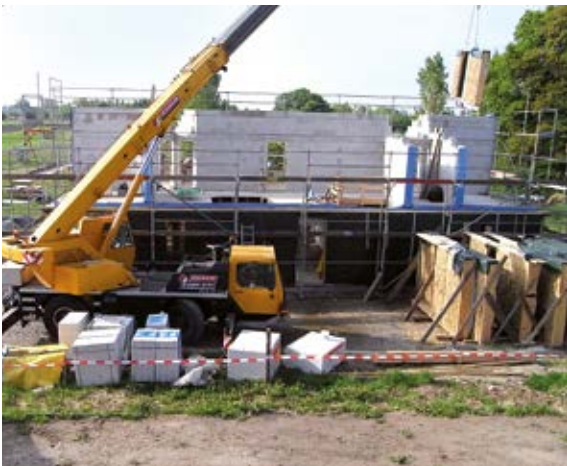
3. Aufstellen der ersten Wand im Obergeschoss.
