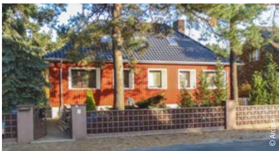
Außen mit Stroh gedämmtes Bestandsgebäude
