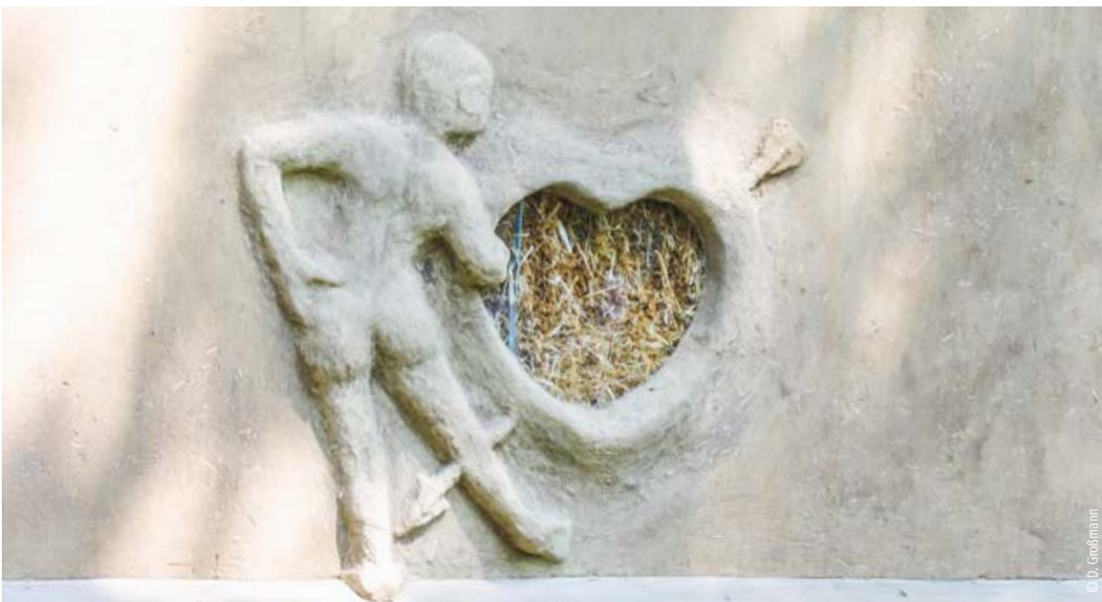
Ein sogenanntes „Truth Window“ zeigt die Strohdämmung.
