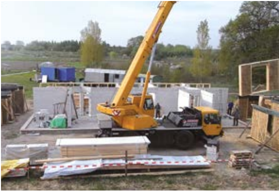
1. Aufstellen der ersten Wand im Erdgeschoss.
