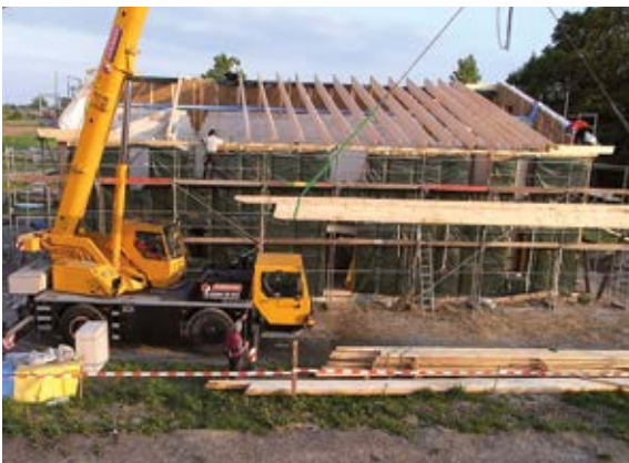
1. Auflegen von Sparren (ohne Element-Vorfertigung).
