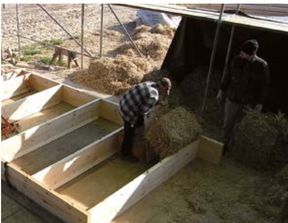
3. Ansatz der Anfangsballen mittels Gleitplatten durch ein bis zwei Personen.
