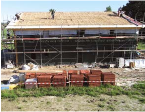
3. Abschluss des Balleneinbaus.
