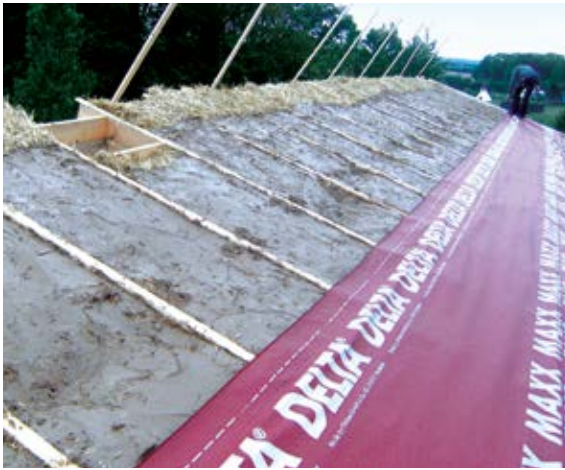
5. Dachstrohballe mit Lehmputzlage und Unterspannbahn.
